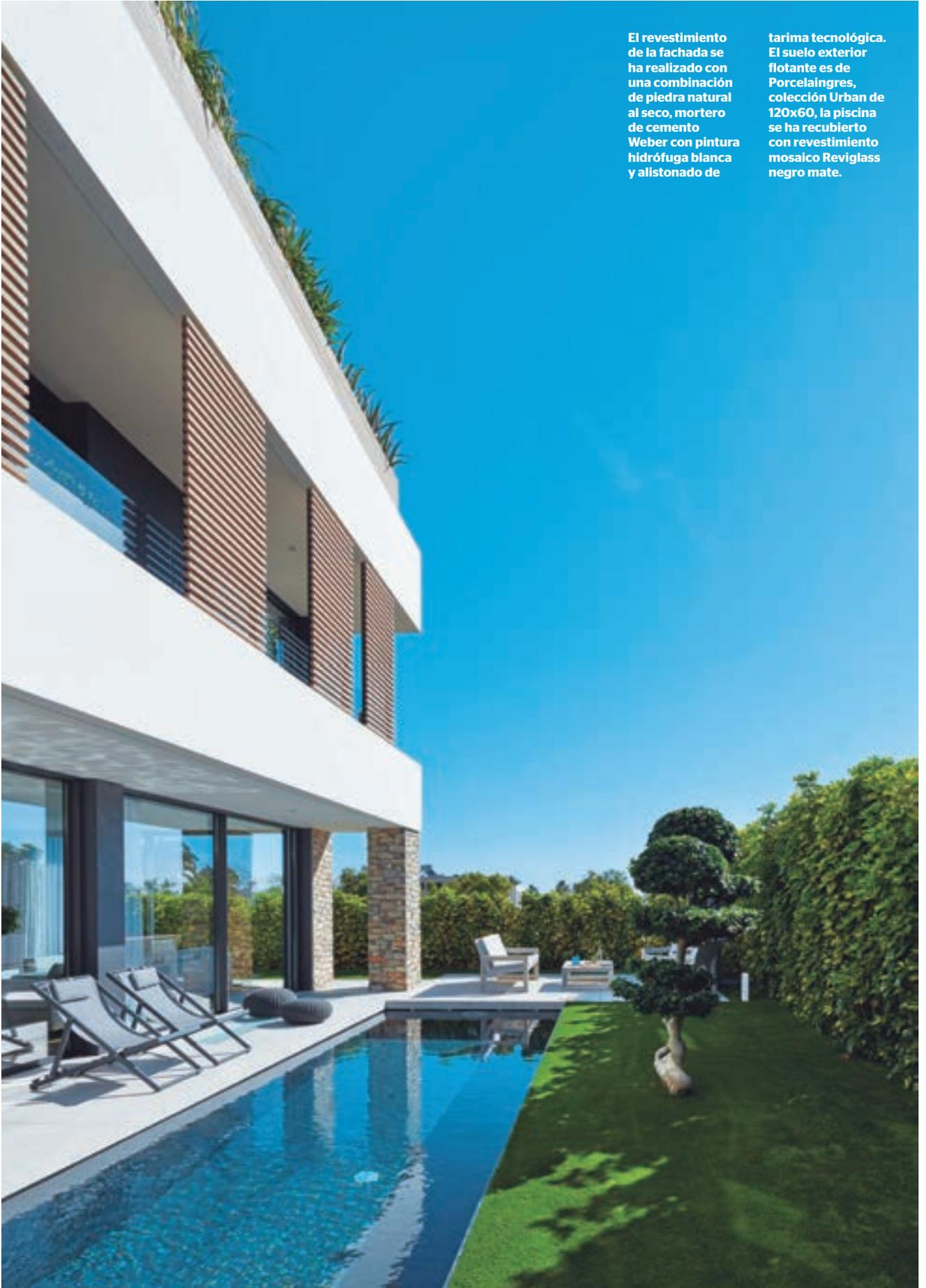
El revestimiento de la fachada se ha realizado con una combinación de piedra natural al seco, mortero de cemento Weber con pintura hidrófuga blanca y alistonado de
